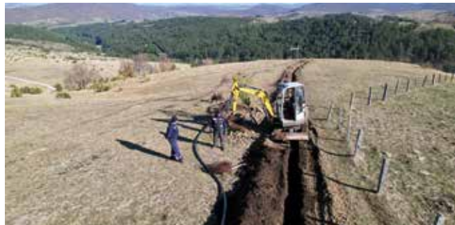
Изградња водоводне мреже
