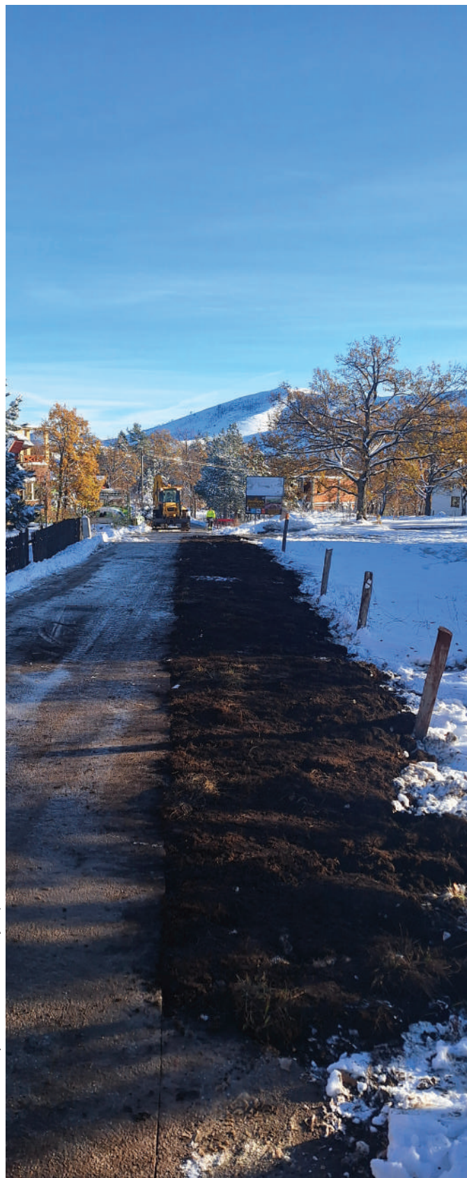
Уклањање дела асфалтне подлоге у Гајевима
