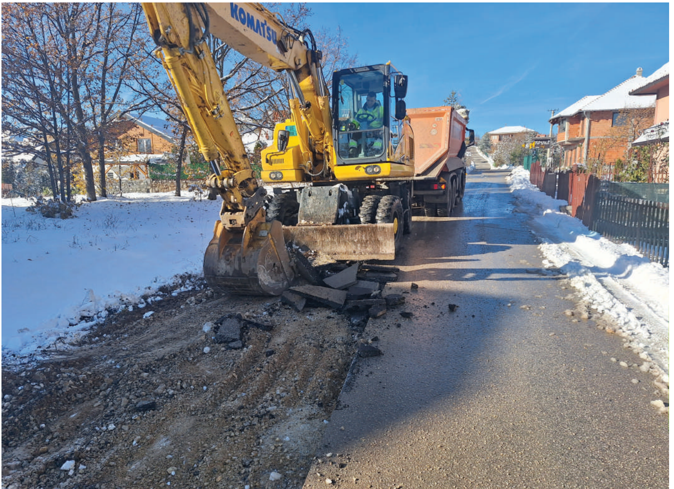
Уклањање дела асфалтне подлоге у Гајевима
