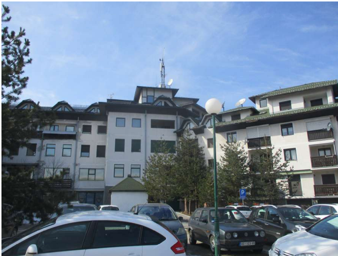
Slika 3.10 – Izgled lokacije na kojoj se planira instalacija bazne stanice
