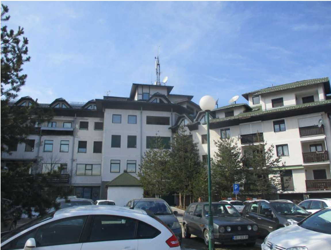
Slika 2.4 Izgled objekta u kome se planira postavljanje nove RBS opreme
