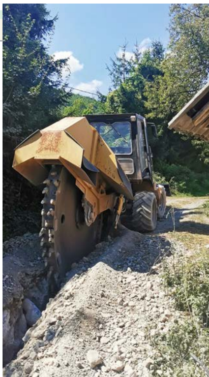
Изградња потпуно нове водоводне мреже у Гостиљу
