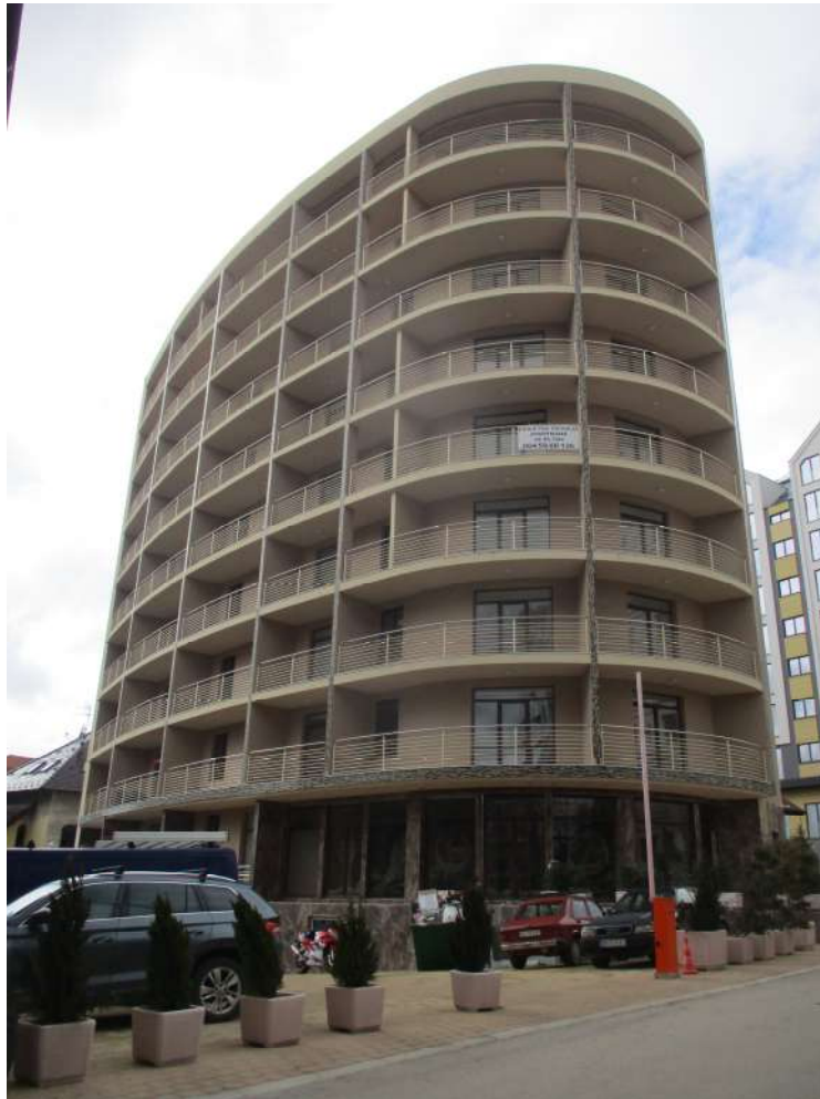
Slika 2.4 Izgled objekta u kome se planira postavljanje nove RBS opreme
