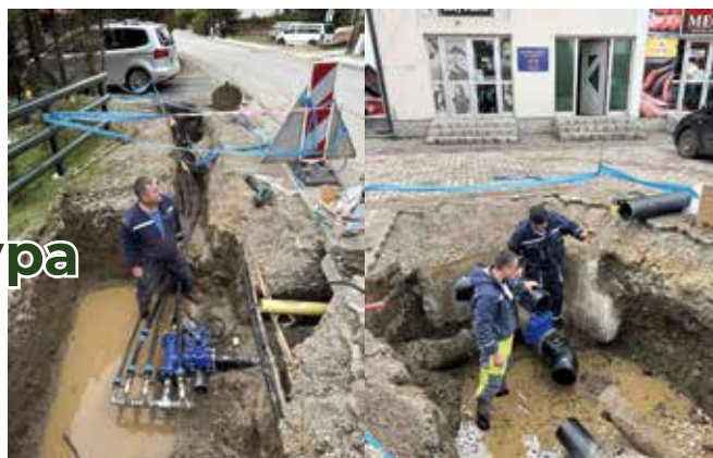
Радови на водоводној мрежи на Златибору
