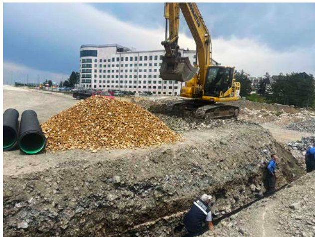
Изградња канализационе мреже
