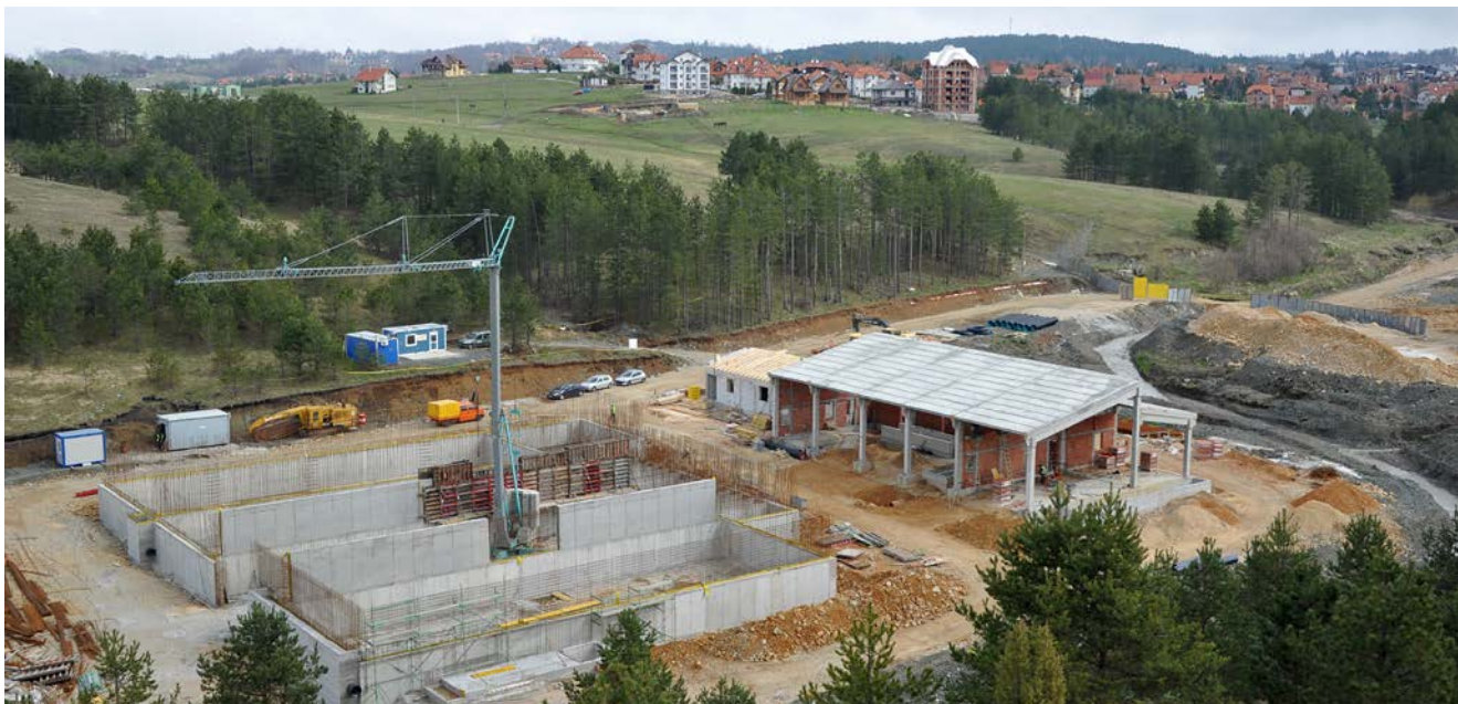
Интензивни радови на Постројењу за пречишћавање отпадних вода
