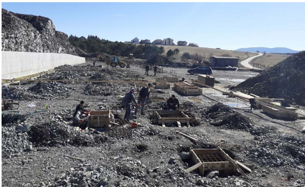
Са лепшим временом, кренуло се и са радовима на изградњи пословног објекта на Златибору
