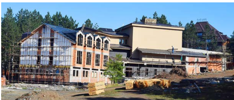
Радови на изградњи Омладинско-културног центра на Златибору у пуном јеку
